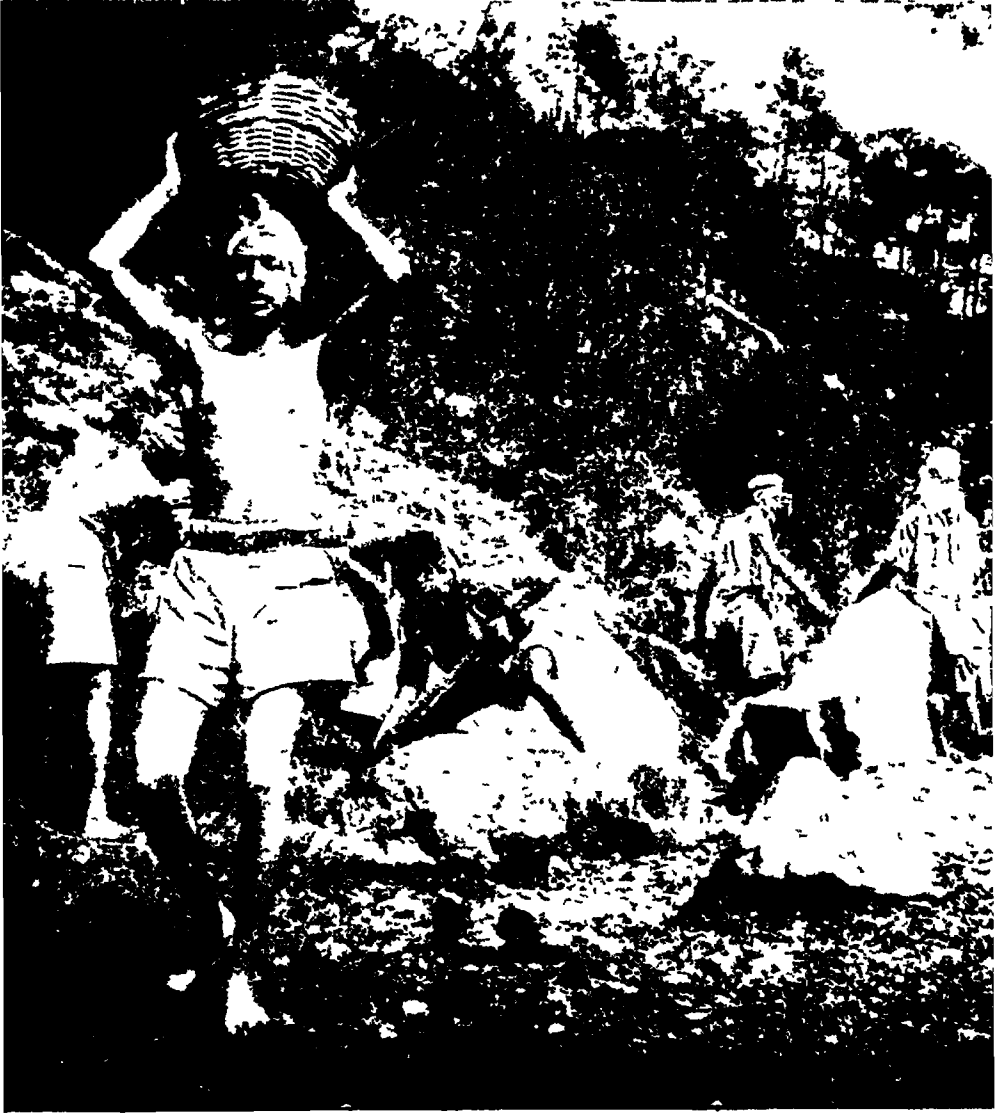
इच्छापूर्वक काम करने वालों के द्वारा सड़क का निर्माण
